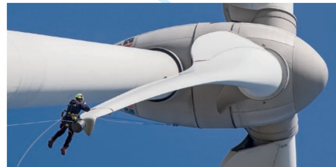
Aus der Froshperspektive: Ein Rotorblatt wird auf Abrieb kontrolliert. Der „Nack“ in der Rotorblattspitze ist ein sogenanntes Winglet und dient zum kontrollierten Strömungsabriss.
