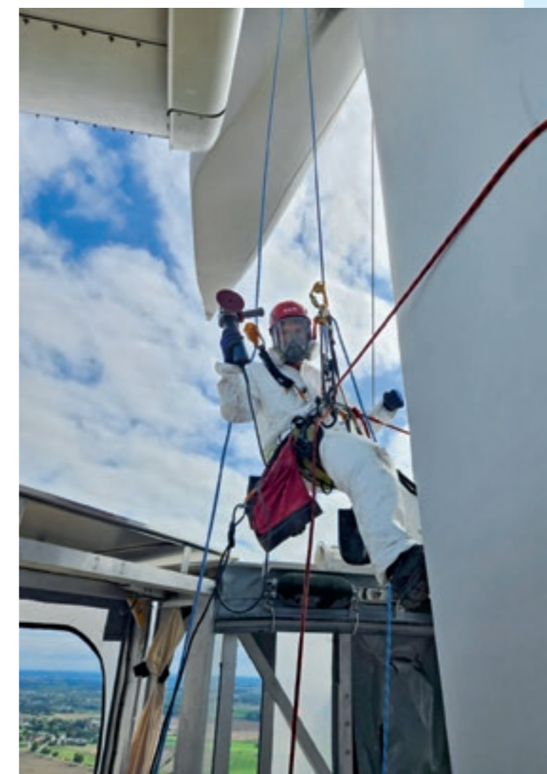
Bei Windrädern ab 100 Metern Höhe kommen mobile Arbeitsbühnen zum Einsatz. Alle Arbeitsgeräte, wie der Schleifer, sind an Seilen gesichert.
