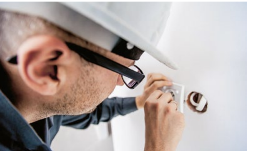
Der Einbau einer Steckdose ist Aufgabe für einen Fachmann.
