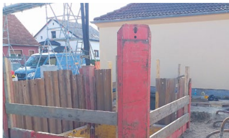
Bau des Ersatz-Pumpwerks.
