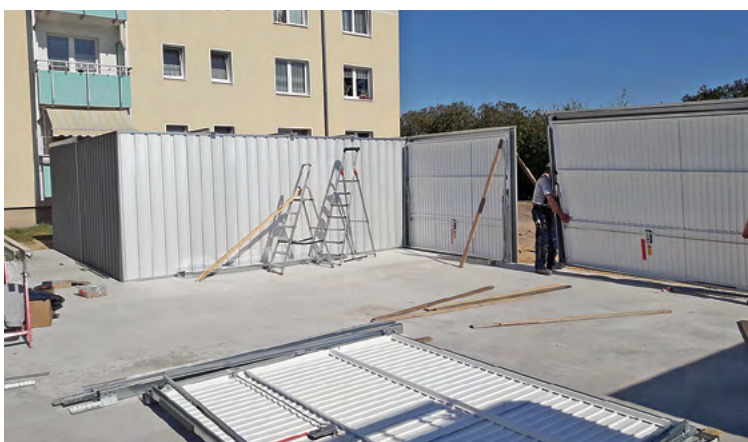
Im April wurden die Garagen auf die fertigen Bodenplatten aufgesetzt.
