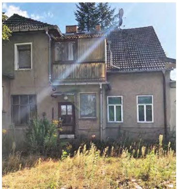
Das baufällige Haus ist bald Geschichte. Es wird einem Neubau weichen.
