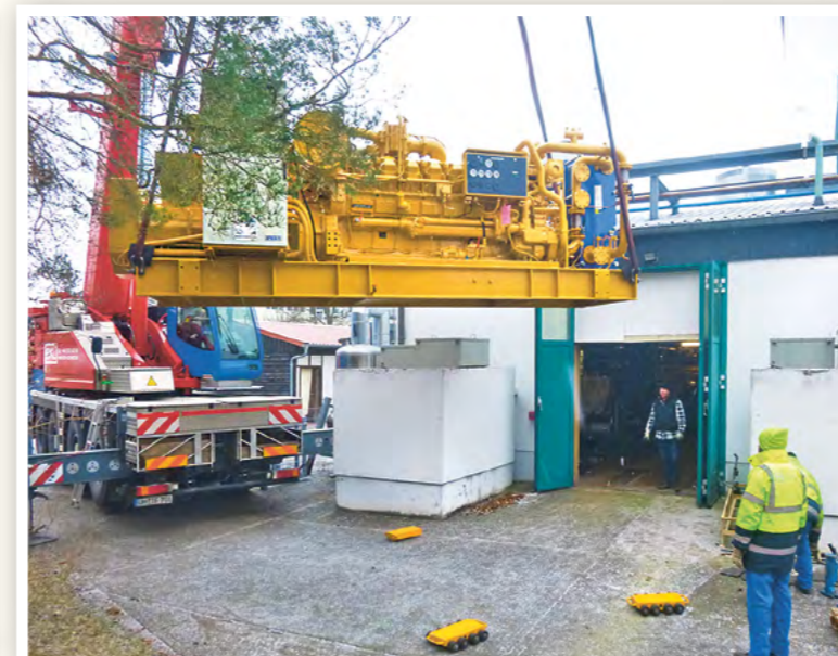
Auch bei seiner Rückkehr ins Stadtwerke-BHKW lotste ein Schwerlastkran die Maschine millimetergenau durchs schmale Tor auf ihre Position.
