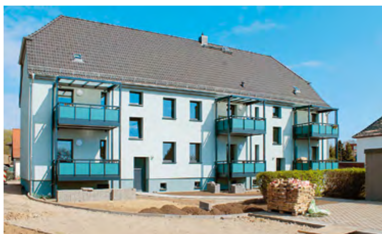
Außen und innen HUI! Hinter der schönen, neuen Fassade in der Neuen Straße sind moderne Wohnungen entstanden.
