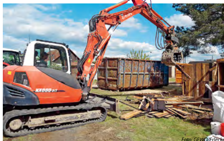
Beginn der Abrissarbeiten auf dem Areal in Zehdenick-Nord.
