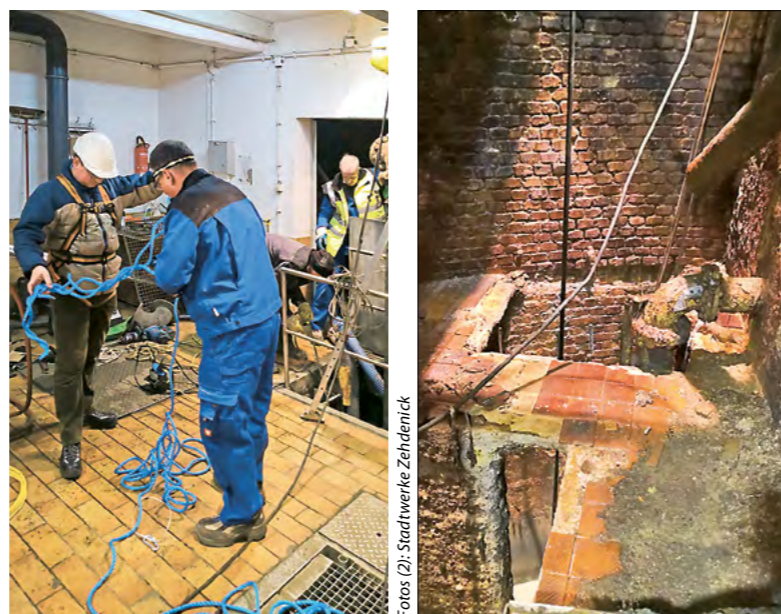
Viele Hände brachten das Pumpwerk über Nacht wieder zum Laufen. Mehr als 60 Jahre „im Untergrund“ haben deutliche Spuren hinterlassen. Foto: (2): Stadtwerke Zehdenick
