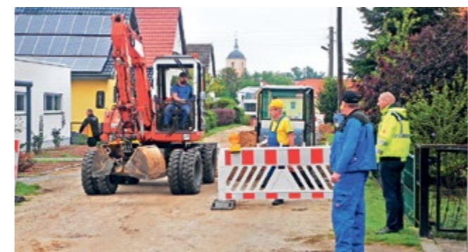
Außer-Haus-Termin beim Meisterbereich Trinkwasser: Steffen Carls macht sich mit der besonderen Baustelle im Amselweg vertraut (siehe auch Seite 1).
