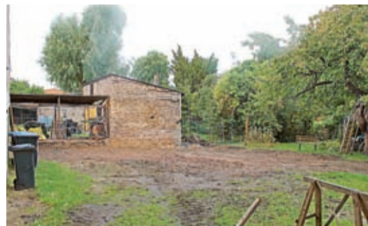
Gähnende Leere? Aber nicht mehr lange! Schon bald sind auch hier die Außenanlagen fertig.
