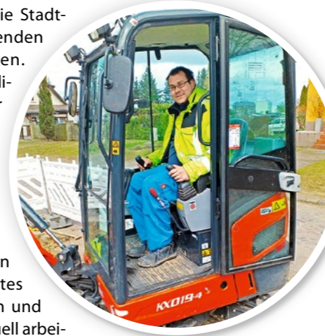
Pumpwerk- und Schacht-sanierungen gehören zu den Hauptaufgaben von Oliver Bähn (oben) und Christian Tamsel.
