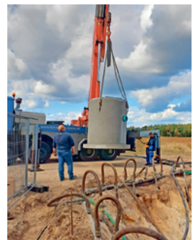
Hier schweben neun Tonnen am Kran. Foto: Stadtwerke
